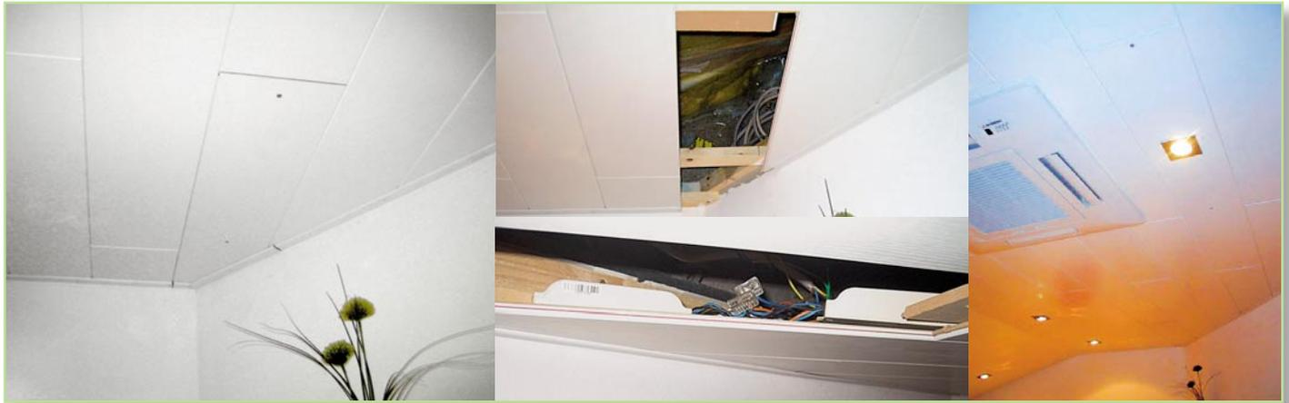
**Bild 2: Unauffällig installierte Wartungsklappen ermöglichen einen leichten Zugang für Wartungs- und Programmierarbeiten. Lösung: einfach bei den Paneelen die oberen Teile der Nuten abschneiden, Panel einsetzen und die Paneele anschrauben. Die Schrauben sind mit farblich passenden Abdeckungen kaschierbar.**
