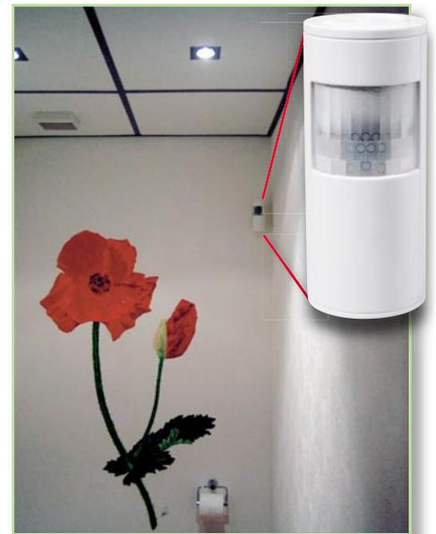
**Bild 5: Der FS20 PIRI „regelt“ über einen FS20 SH im Schaltschrank das Schalten von Licht und Belüftung in der Kundentoilette.**
