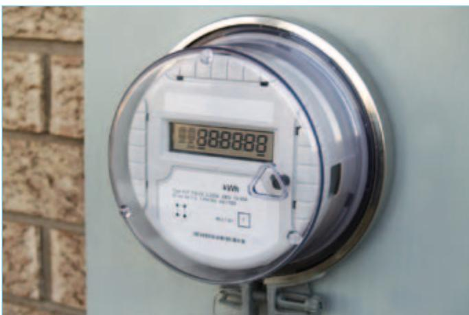
Bild 6. Ein ZigBee-fähiger intelligenter Stromzähler.
