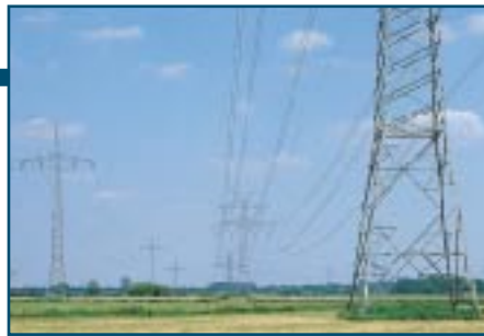
Bild 6: Hochspannungstrassen strahlen ebenfalls ein erhebliches elektrisches und magnetisches (niederfrequentes) Feld ab. Schon die Bauvorschriften z. B. in Schweden und Deutschland zeigen, wie ernst man es jeweils mit den Gefahren nimmt, die hiervon ausgehen. Während in Schweden mindestens 30 - 50 m Abstand zu halten ist, gibt es in Deutschland Fälle, wo der Hochspannungsmast im Hausgarten steht.
