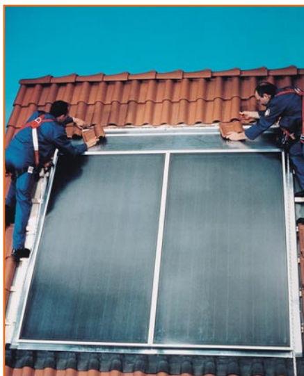
Bild 2: Gibt ein harmonisches Bild - Indach-Montage eines Sonnenkollektors. Foto: Vaillant
