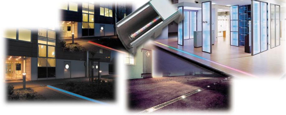
Bild 21: LED-Orientierungsbeleuchtung: Diskret, praktisch, wasserdicht und wegweisend – RGB-LED-Module im Drainagesystem. Fotos: ACO Drain/Insta
