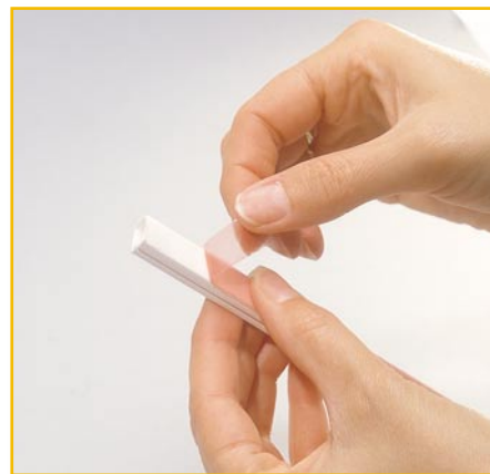
Bild 3: Entfernung der Schutzfolie vom Installationskanal
