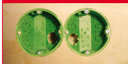
Bild 7: Die Schalterdosen werden eingesetzt. Nicht die Durchbrüche für die Verbindungsleitungen vergessen!
