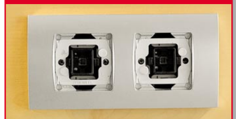
Bild 9: Das Einsetzen von Taster-Einsatz, Abdeckrahmen und Halter erfolgt wie beim normalen Schaltereinbau.
