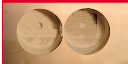
Bild 6: Mit der Bohrkrone bzw. Lochkreissäge setzt man die Wandlöcher und arbeitet ein Verbindungsloch zwischen den Löchern ein. Alternativ kann man auch eine Mehrfachdose (siehe Bild 2) einsetzen.
