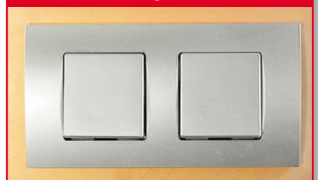
Bild 10: Mit dem Aufsetzen der Taster-Abdeckungen ist die Montage abgeschlossen.
