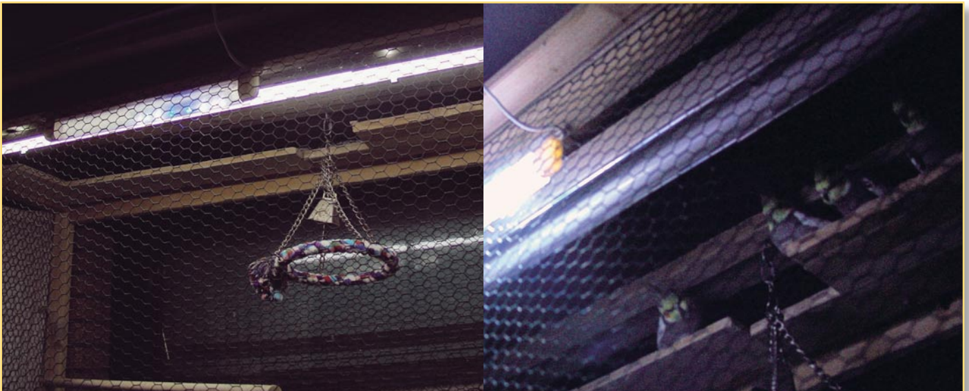
Bild 1: Mondlicht in der Vogelvoliere – so können die Vögel sich auch nachts orientieren, wenn sie etwas aufschreckt. Links sieht man die für die Vögel verdeckte Montage hinter der hier ebenfalls eingeschalteten Tageslicht-Leuchte, zudem sind die LEDs nach außen gerichtet. So können die Vögel die Leuchte selbst nie sehen. Rechts das Ganze in der Nacht in Aktion. Lediglich die Nachtsichtfunktion und die Abschaltung aller Automaten der Digitalkamera macht hier die Vögel bei bereits gedimmter Leuchte, die jedoch immer noch alles überstrahlt, sichtbar. Dennoch reicht die Beleuchtung mit nur wenigen LEDs für die Tiere zur Orientierung.
