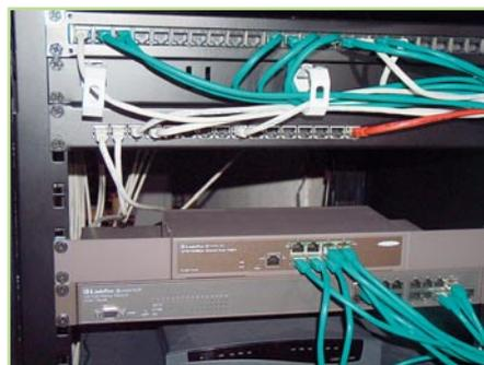
**Bild 6: Die Netzwerkverkabelung ist in einem 19"-Gestell zusammengefasst.**
