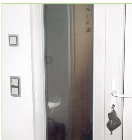
Bild 19: Über die vier Taster an der Haustür sowie über die Profile-Bedienerfläche sind komplexe, individuelle Szenarien für jedes Familienmitglied auf einen Tastendruck auslösbar.
