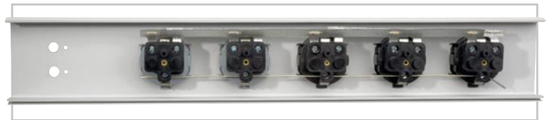
Bild 6: Die Stromschiene für die jeweils linken Kontakte ist jetzt eingesetzt.
