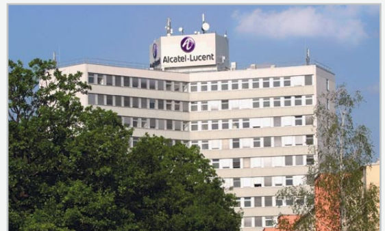
Bild 10: Standpunkt der Sektorantennen des LTE-Testnetzes
