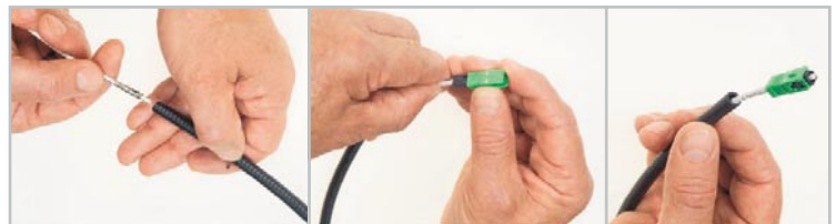
Bild 16: Bei Miniflex-Kabeln wird nur das Kabel mit ankonfektionierter Ferrule eingezogen. Am Ausgang des Leerrohrs wird die Ferrule durch wenige Handgriffe zum vollständigen Stecker ergänzt. (Quelle: Anpeq)
